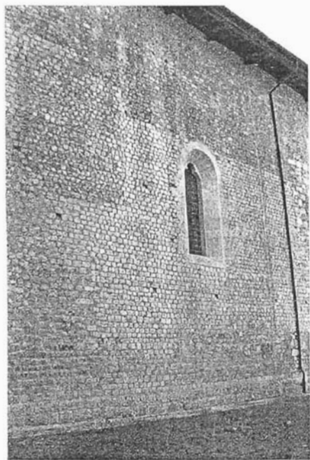
Figg. 20a-b – L'Aquila, Basilica di Collemaggio . Rilievo di un campione di muratura e vista della cortina sul fianco sinistro.
