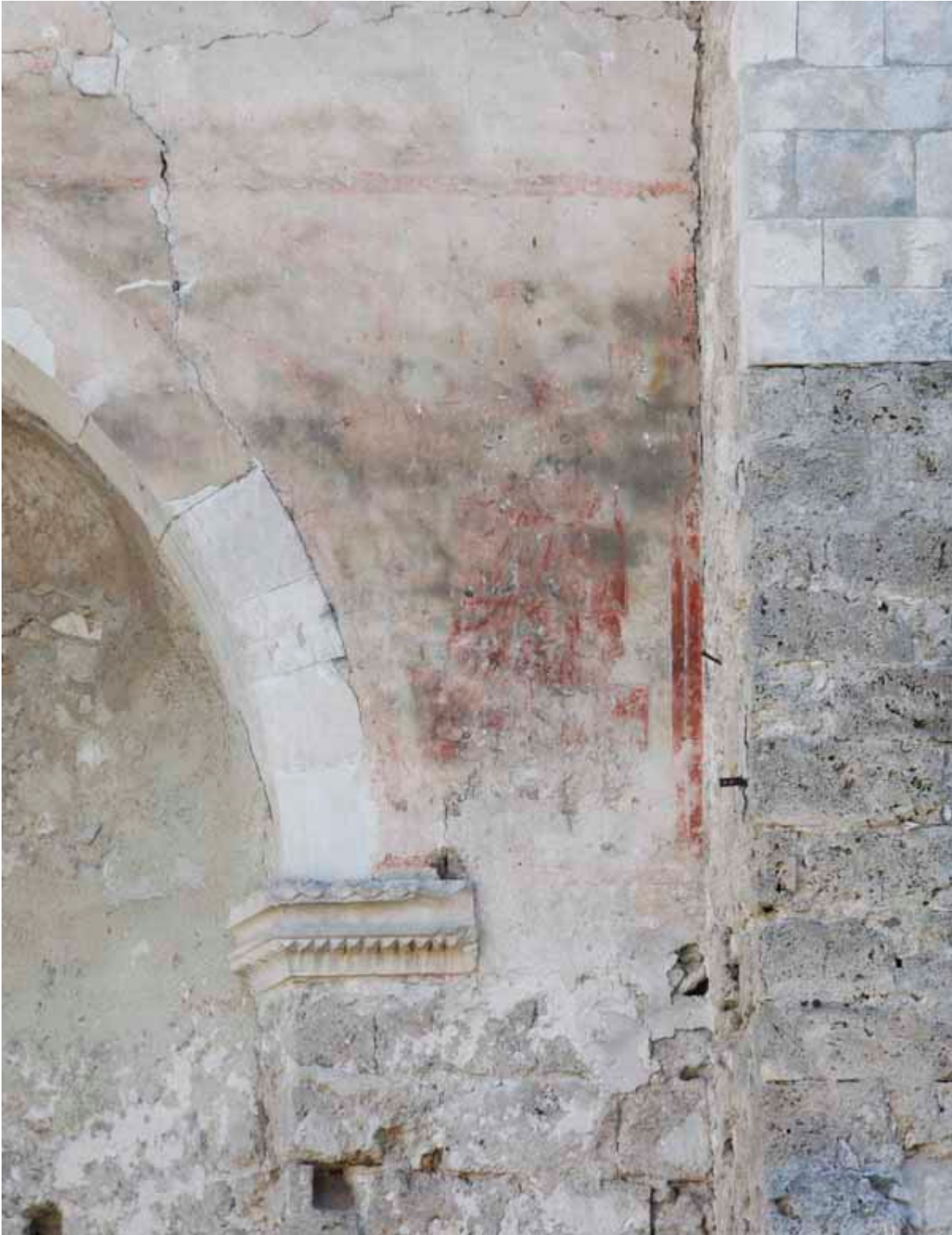
Particolare dell'arco absidale
